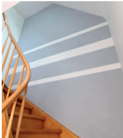
3 Kalkpresstechnik in Betonoptik und alte Holzterpfe – eine spannende Kombination.
