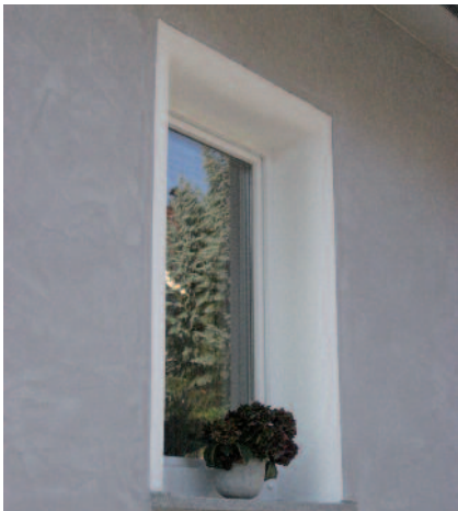
2 Abgerundete Fensterleibung bei WDVS, Kalkpresstechnik als Fassadenoberfläche.
